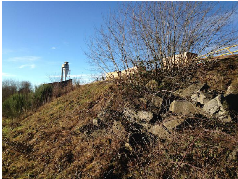
Figure 21 : Photo du talus
